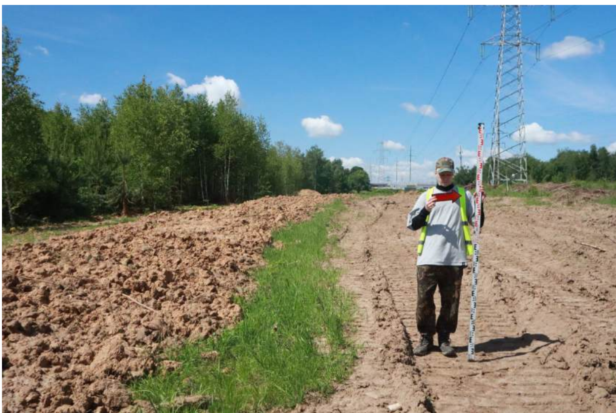
Рис. 26. Обеспечение сохранности ОКН федерального значения «Поселение Ольгинское» в г. Нижний Новгород. 2026 г. Участок проектирования. Точка фотофиксации 3. Вид с В.
